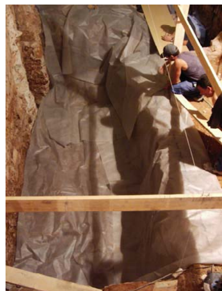
062.Treballs col·locació del g ...
