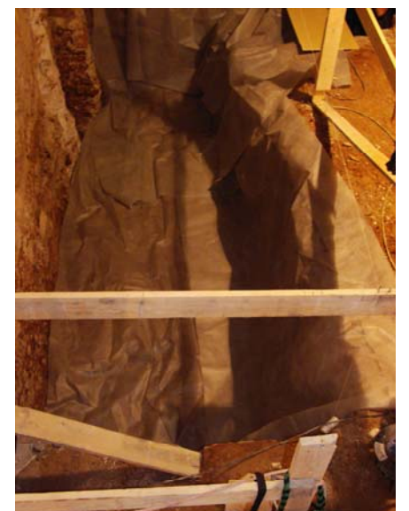
063.Col·locació del geotextil. ...
