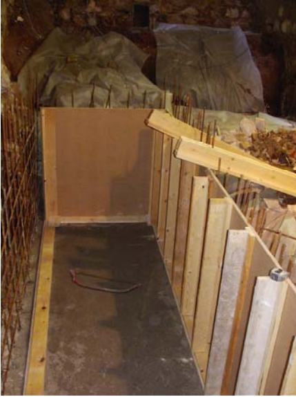
064.Treballs col·locació de l'e ...
